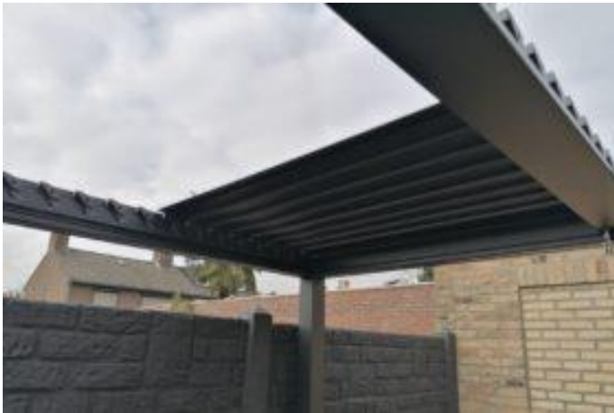
De lamellen van het dak in elkaar gezet zodat het dak stilaan dicht en afgewerkt is
