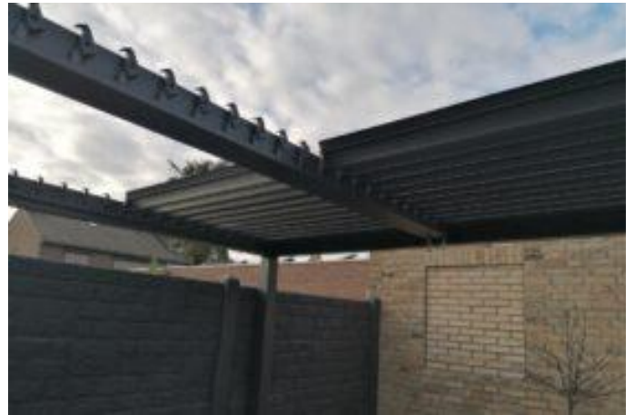
De lamellen van het dak in elkaar gezet zodat het dak stilaan dicht en afgewerkt is
