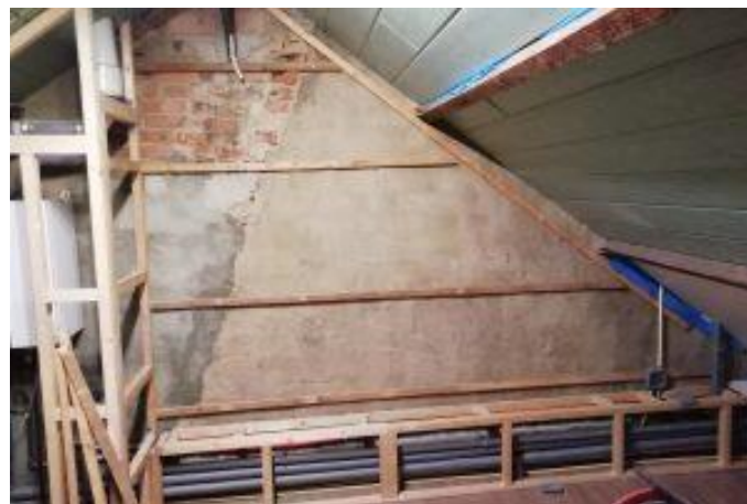
Nu is men begonnen aan de andere zijde met het uitragellen van de muur.
